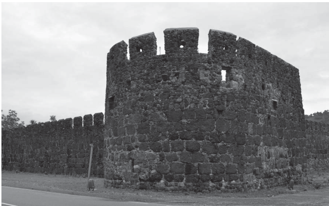
Fig. 1. Gonio. Południowo-zachodni narożnik umocnień fortu. Fot. O. Kubrak.
