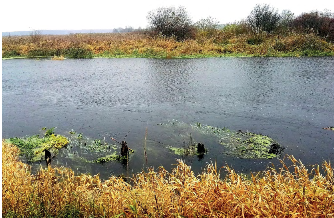
Ryc. 4. Widok na pale wystające z wody (fot. A. Brzóska)
