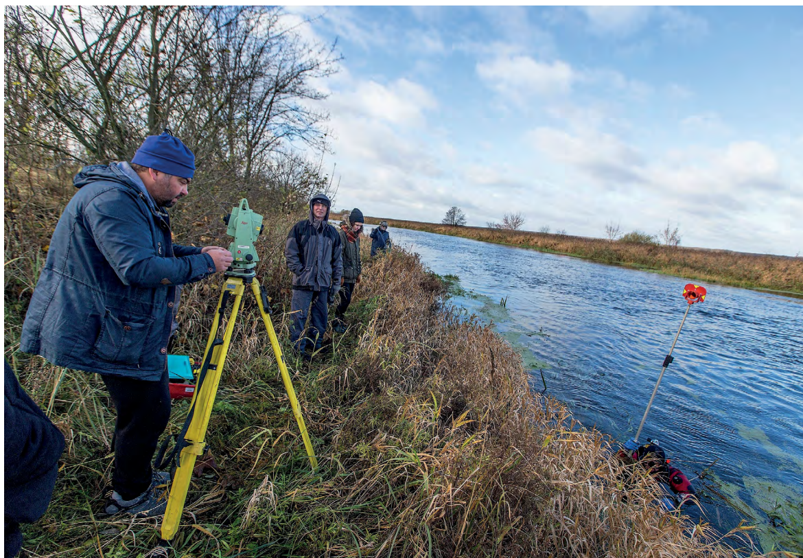
Ryc. 3. Pomiary konstrukcji tachimetrem elektronicznym (fot. A. Kozłowski)
