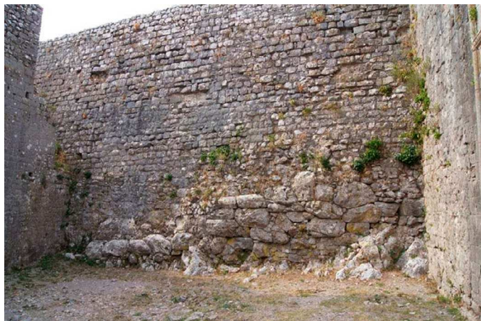
Ściana barbakanu nadbudowana na murze „cyklopim” (fot. M. Lemke)
