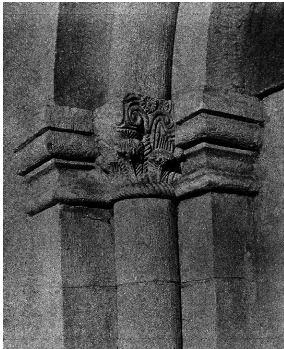
Kapitel półkolumniki i gzyms portalu południowego cerkwi św. Pantelejmona (wg J. Peleńskiego)
