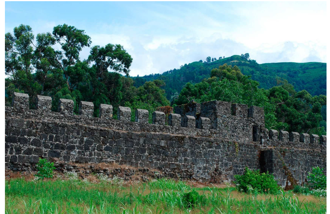
Mur i wieża fortu. Strona wschodnia. Sezon 2014 (fot. M. Czapski)
