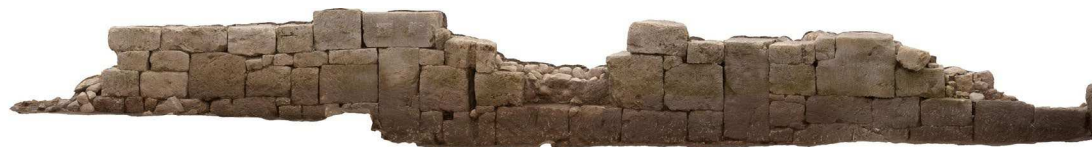
Przykład wykonania fotogrametrii łańcucha muru (oprac. M. Bogacki)
