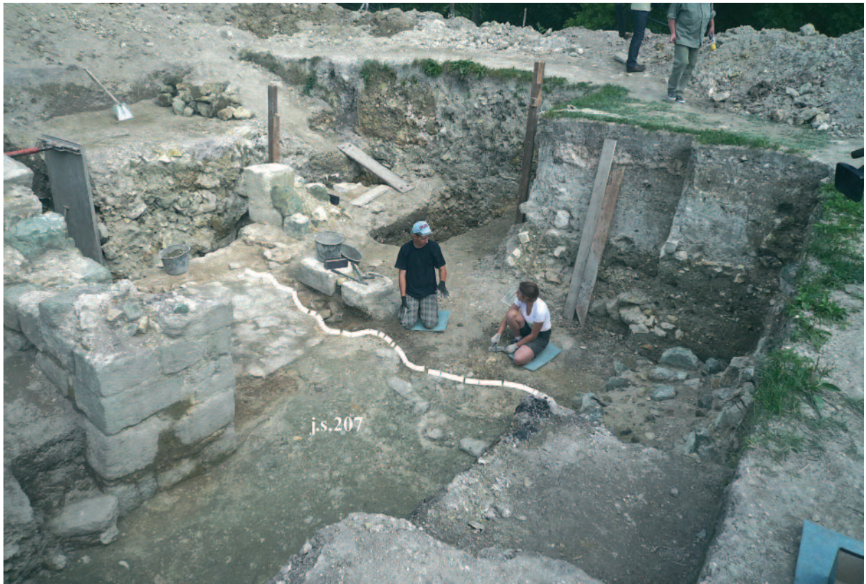
Ryc. 16. Wykop 23: część bramna z widoczną uszkodzoną – zaznaczona białą linią – warstwą „posadzkową” zielonego piasku glaukonitowego (j.s. 207) (fot. A. Buko).
